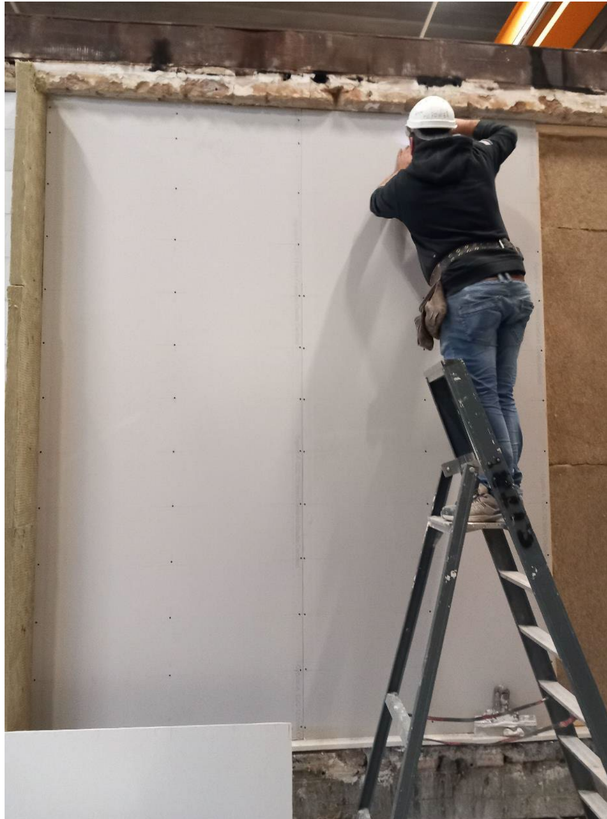
Foto C. 2: Wand tijdens de bouw (vuurzijde)
