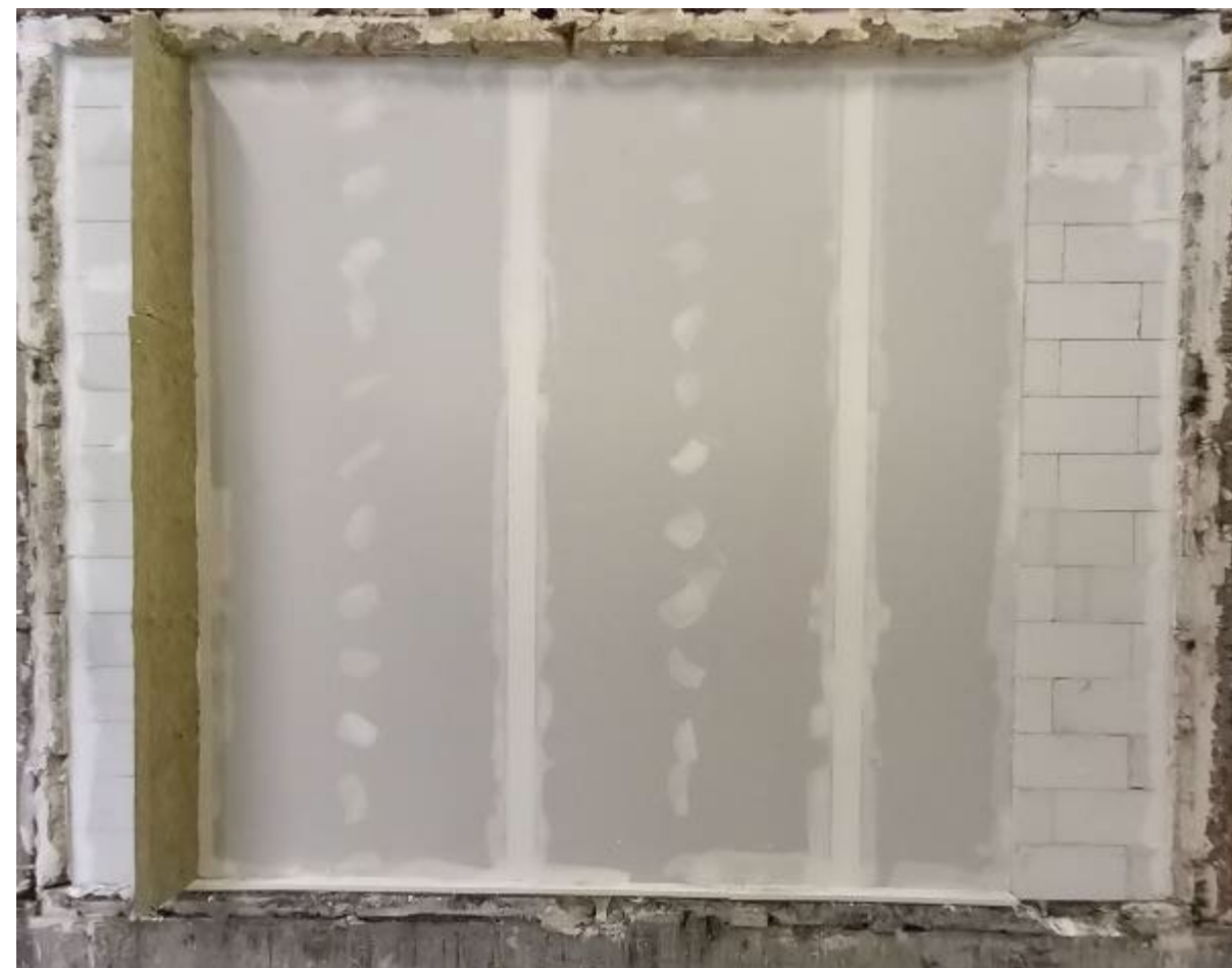
Foto C. 3: Wand tijdens de inbouw (vuurzijde)
