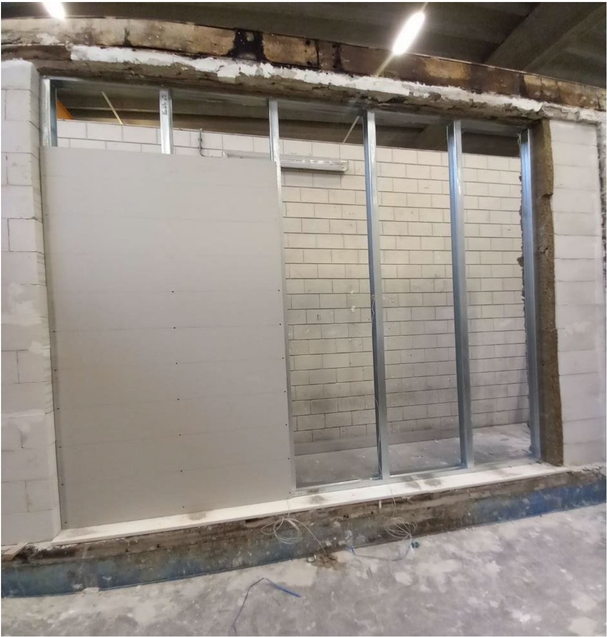
Foto C. 1: Wand tijdens de inbouw (niet-vuurzijde)
