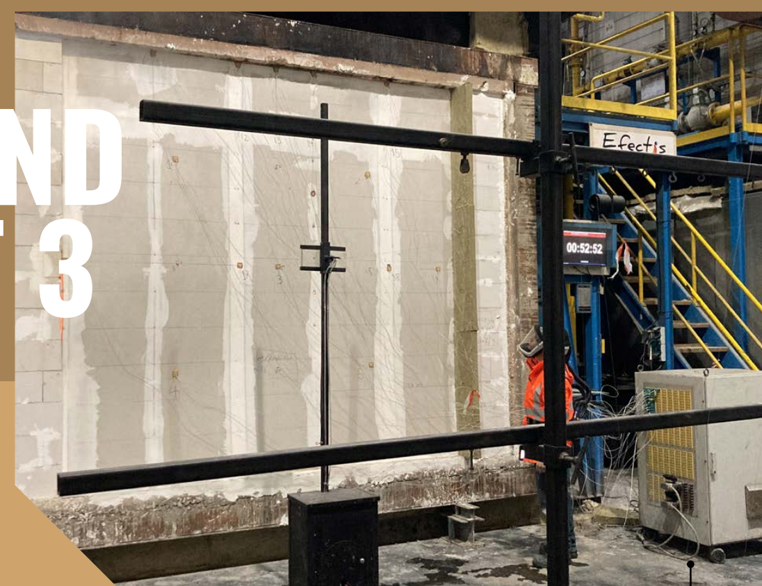
Afbeelding 7 - Brandtest 3 op metal stud wand
