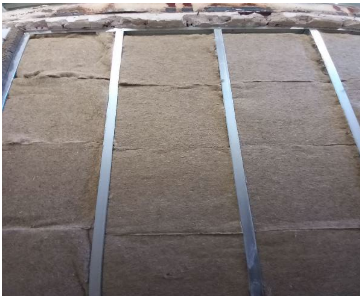
Foto C. 2: Wand tijdens de inbouw (isolatie)
